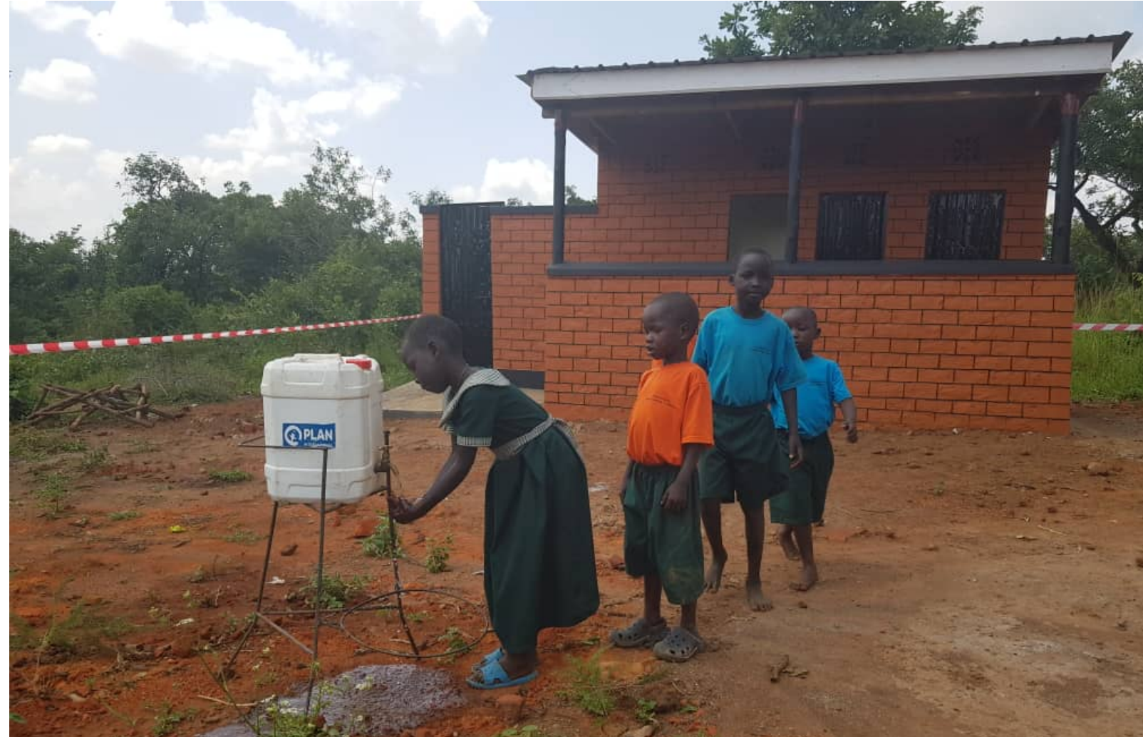
Sanitärgebäude in Lamwon
